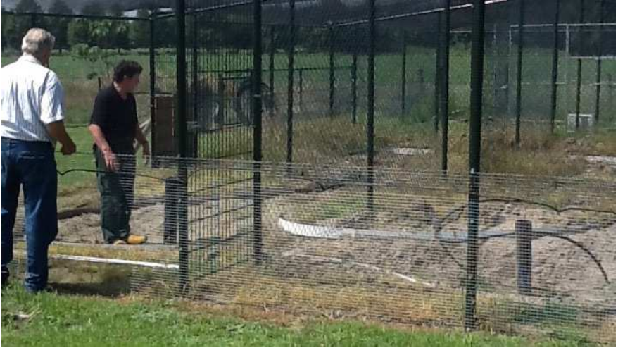
Verblijf in aanbouw voor wadvogels
